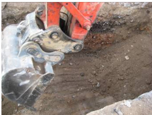
Foto núm. 6. Excavació de la rasa amb retroexcavadora
