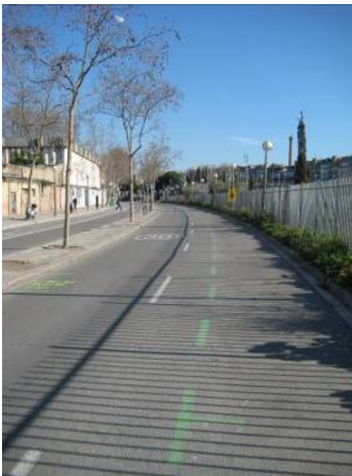
Foto núm. 1. Inici dels treballs. Passeig de la Circumval·lació.
