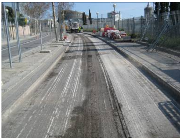
Foto núm. 4. Passeig després d'haver fresat l'asfalt.
