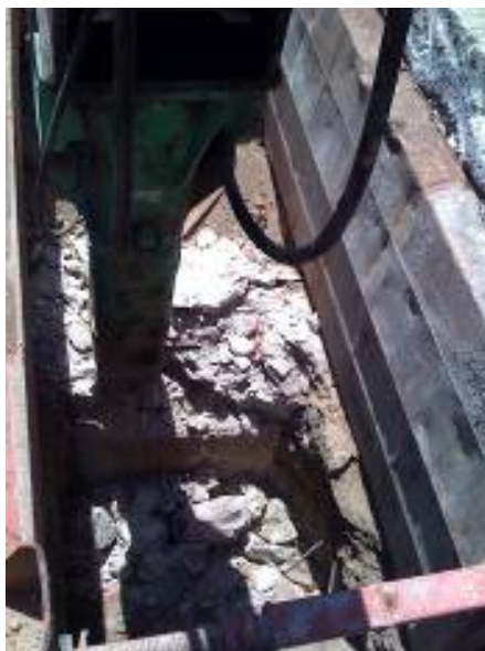
Foto núm. 18 : Detall de la destrucció del mur 1
