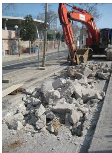
Foto núm. 5. Inici de l'obertura de la rasa.
