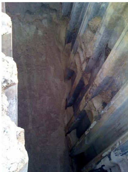
Foto núm. 12. Procés d'excavació amb les taules estaques i les sorres que surten molt netes.
