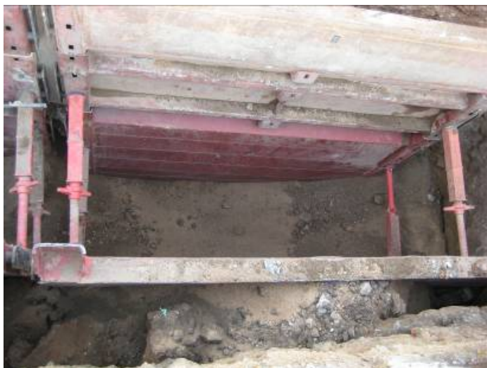
Foto núm. 9. Un tram de la rasa amb el sistema de planxes.
