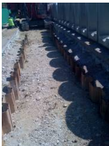
Foto núm. 10 Màquina clavant les taules estaques
