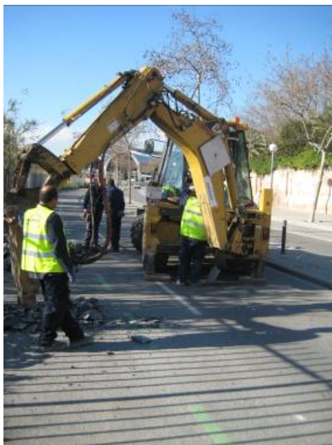
Foto núm. 2. Excavació de les cales
