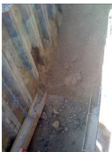
Foto núm. 11. Procés d'excavació amb les taules estaques .
