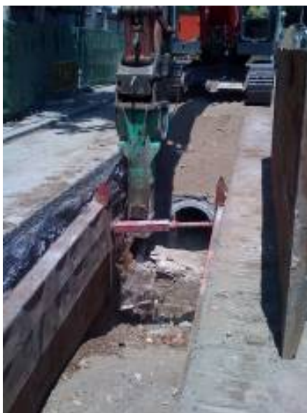
Foto núm. 19 Mur 2 en fase de destrucció.
