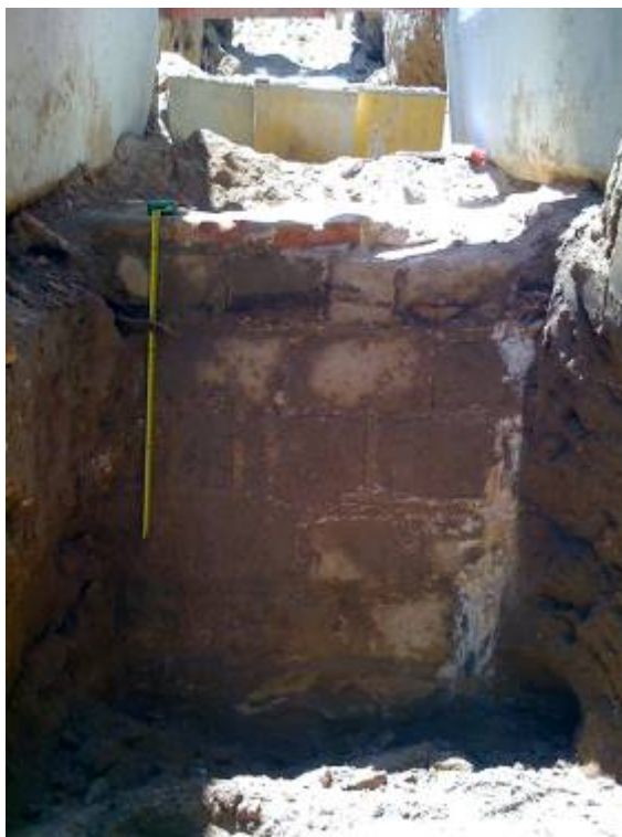
Foto núm. 14. Mur 1 detall de la cara interior.
